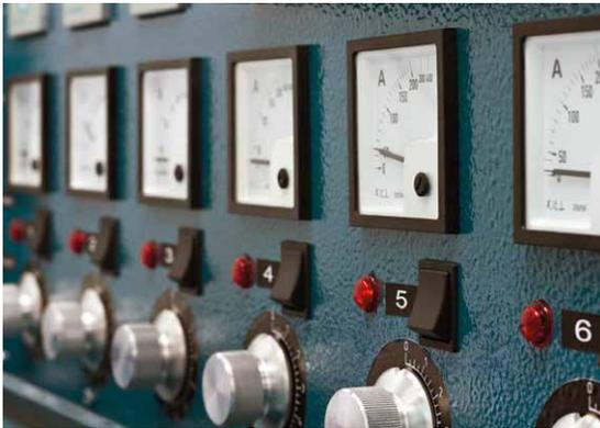
Questi strumenti di misura sono idonei a misurare direttamente i valori correnti dei circuiti ad alta corrente elettrica. L'estensione del campo di misura avviene con lo shunt, lo strumento di base del campo di tensione 0 ... 75 mV deve essere collegato ai contatti di misura dello shunt. Per lo strumento di base di misura può essere ordinato il quadrante con campo di misura di 0-X, secondo la tabella allegata.
