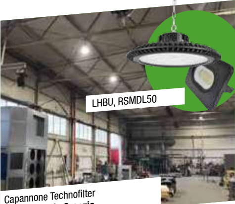
Capannone Technofilter Beli Manastir, Croazia
